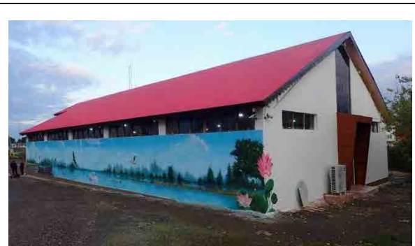
نمای بیرونی (پشت ساختمان)
