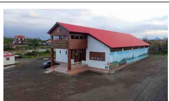
نمای بیرونی (جلوی ساختمان)
