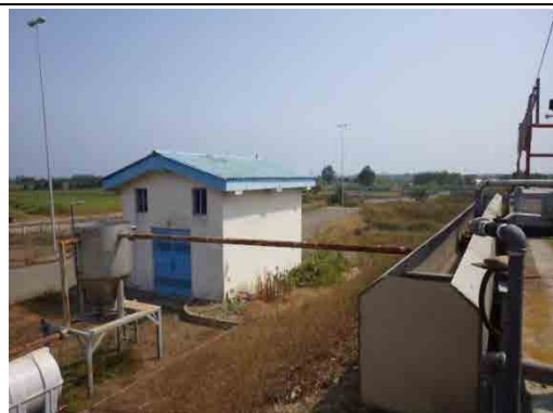
流入ポンプ場
