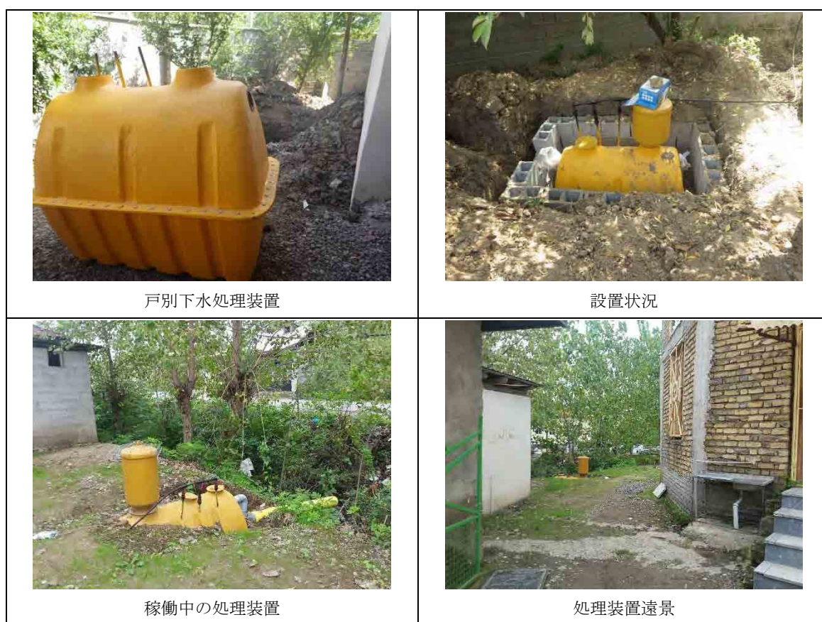
図 6.6-8 Mobarak Abad 村の戸別下水処理システム
