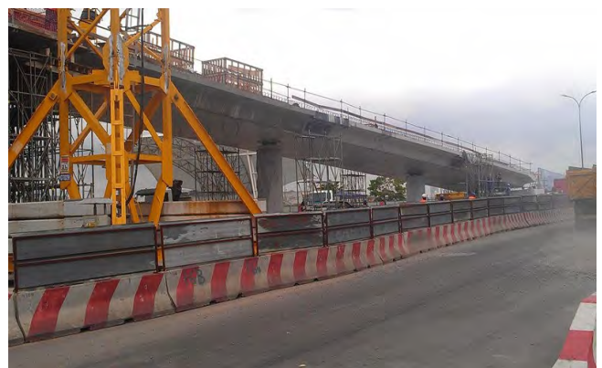
Partie de la rampe, dalles elegies (après coulage du béton)
