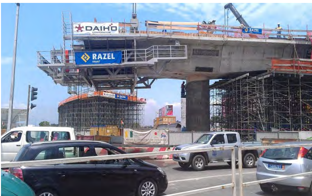
Partie de construction en porte-à-faux
