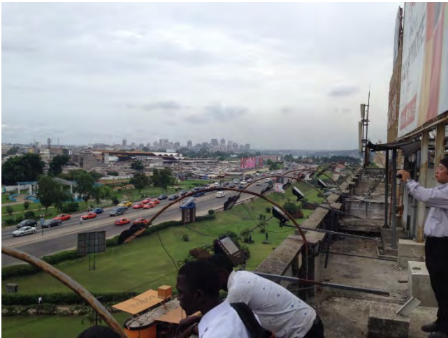
Vue vers le nord le long du boulevard de Gaulle
