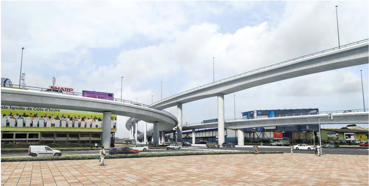
Vue de la partie centrale de l'échangeur à partir du côté ouest
