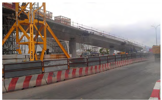
ランプ部 中空床版部 (Co 打設後)
