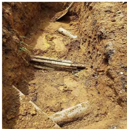
写真 2.4 地下埋設ユーティリティ試掘調査
