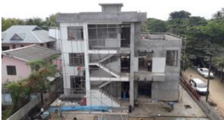
写真1-1 簡易な足場の建設現場 (2016. 12. 7)
