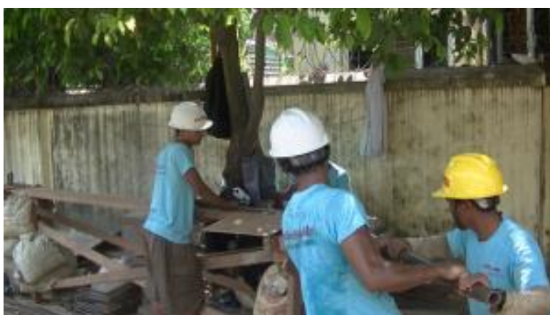
写真3-5 建設現場での鉄筋加工作業の調査 (2016. 3. 23)
