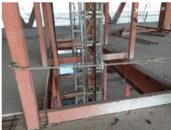
写真1-3・4 安全管理が不十分な高層建設現場 (2019. 2. 24)
