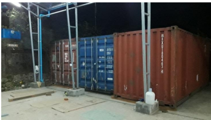
写真3-10 コンテナ設置 (2017. 1. 14)
