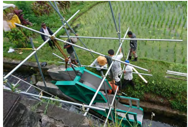
水車据付工事 (2017年9月)
