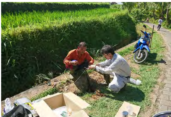
電線埋設工事 (2017年8月)
