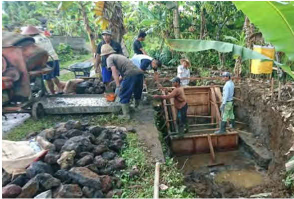
土木工事 (2017年5月)
