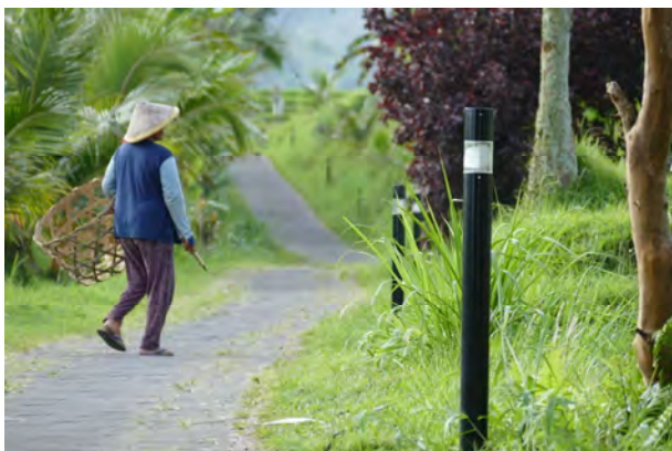
街灯 日中の様子
