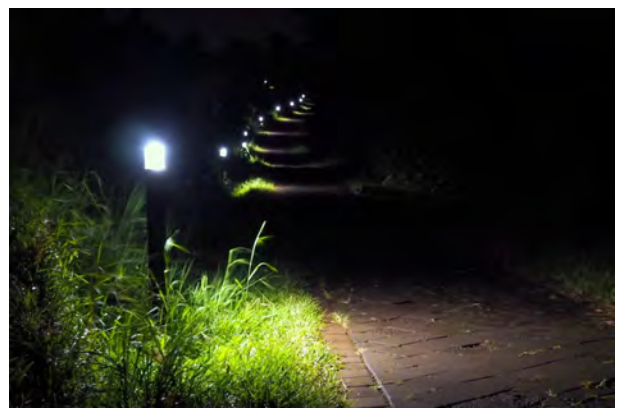
街灯 夜間点灯の様子
