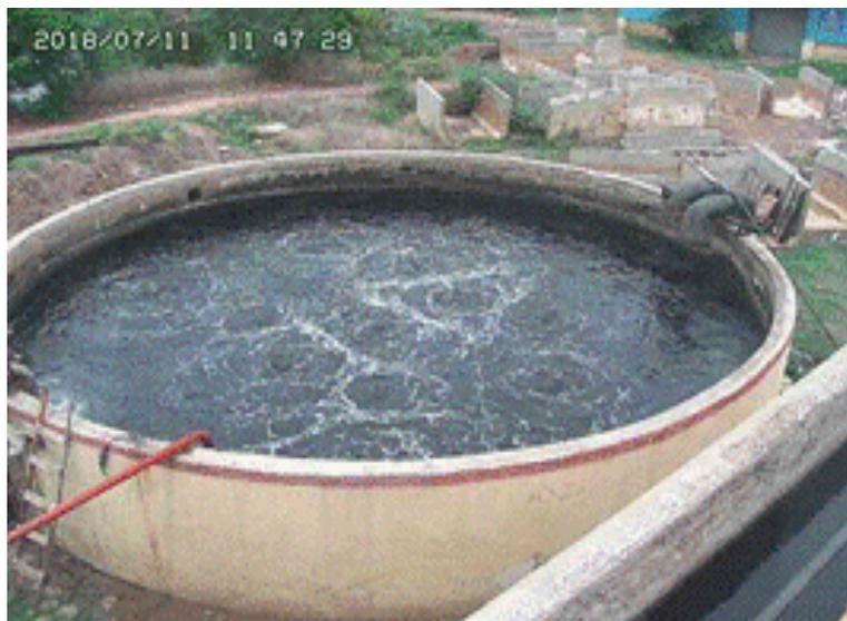
写真5：対象施設の監視画面（原水調整槽）
