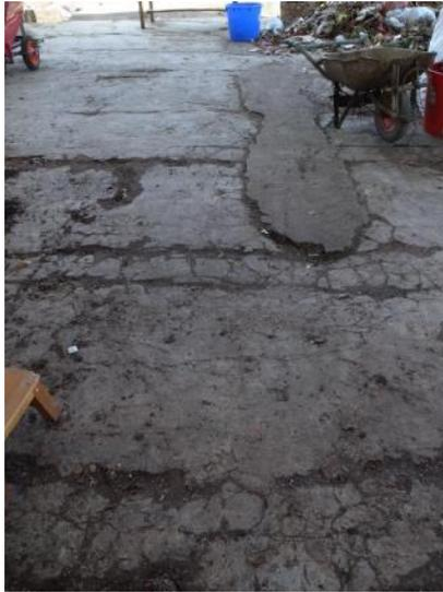
図 27 重量物を置いたために沈み込んだ土台を補強した跡
