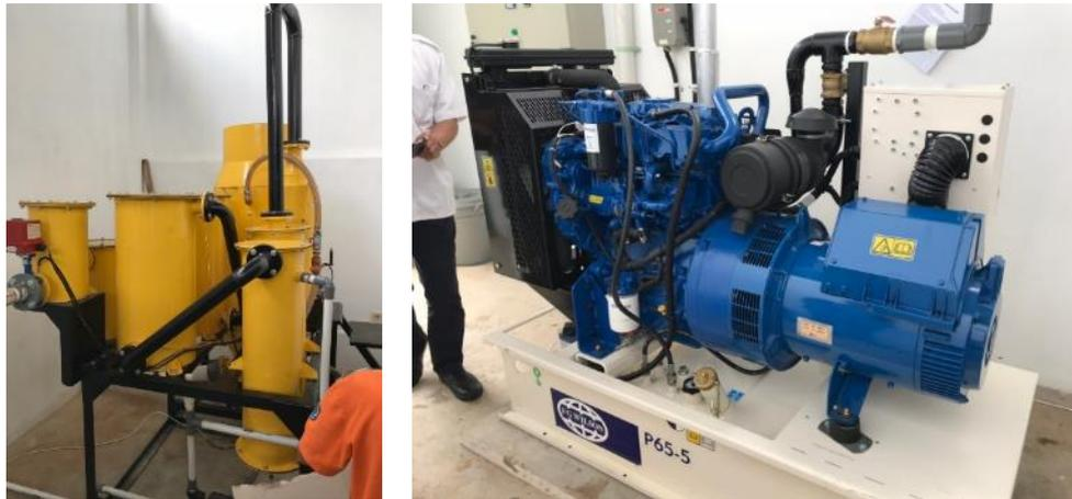
図 15 左：ガス化装置、右：ガスエンジン発電機
