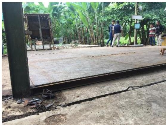
図 30 H 鋼と鉄板による補強工事
