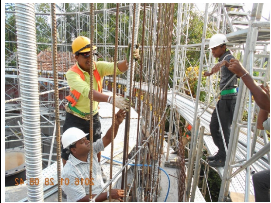
PC タンク側壁施工中 配筋作業
