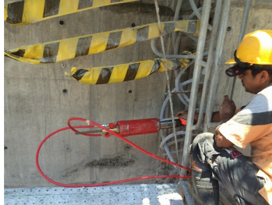
円周方向 PC 鋼材緊張作業 側壁に圧縮力を導入する作業
