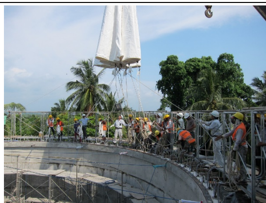
エアードーム空気膜設置作業
