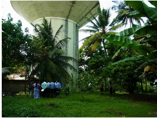
工事着手前の現場 Beruwala OIC 場内
