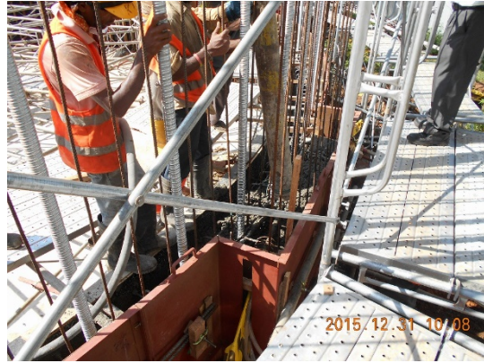
PC タンク側壁の PC 鋼材定着柱 コンクリート打設
