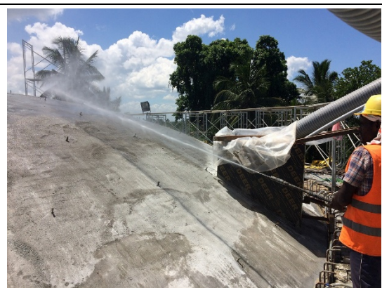
モルタルドーム 散水養生
