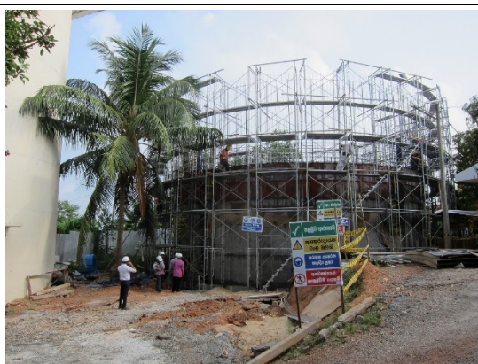
現場施工状況 進捗率 50%
