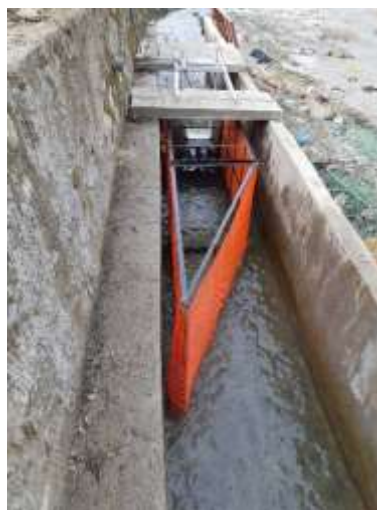
茨城製作所で試作開発したゴミネットを NYSE で製作し(左)、水路にゴミネット設置(右)した際の写真
