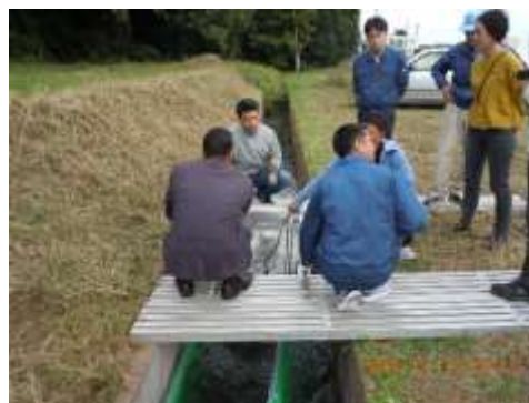
モータ稼働を振動で確認
