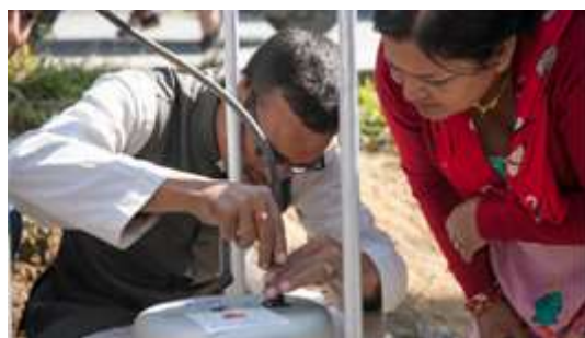
接続部分の確認
