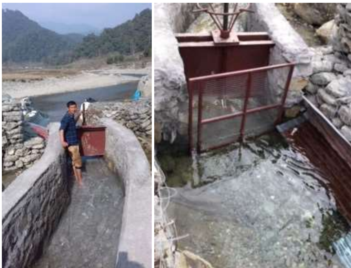
完成した水路に、水門とゴミ除去フィルターを設置
