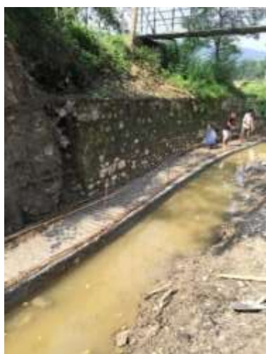
水路工事途中経過
