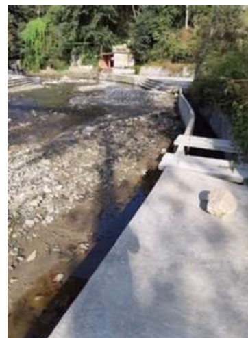
川の片側に水路工事
