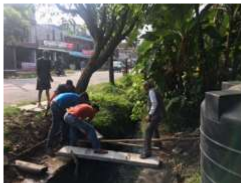
水路へ足場板設置
