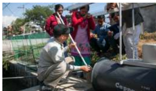
プロペラに付着したゴミの除去方法
