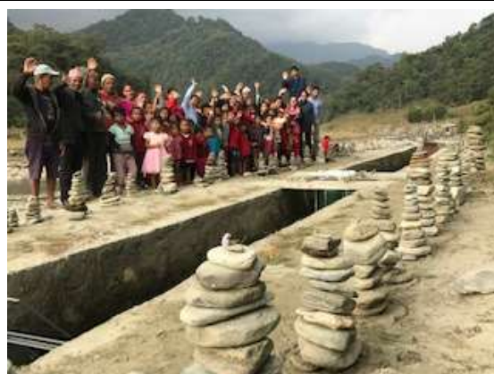
清掃した水路の周りに石積
