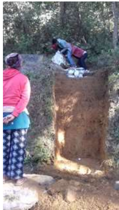
安定した水量の導水と、落ち葉や小石など除去のため水路補修を行った
