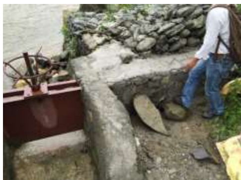
水路入口付近の石積（ガビオンロック）補強対策と側壁補強
