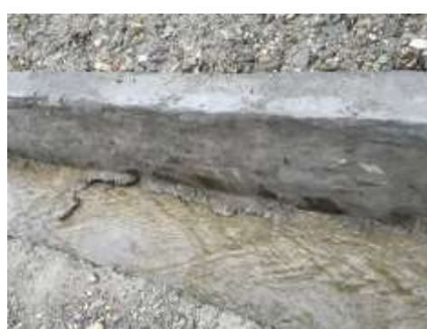
水路入口付近の石積（ガビオンロック）補強対策と側壁補強
