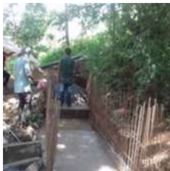
安定した水量の導水と、落ち葉や小石など除去のため水路補修を行った
