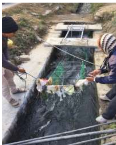
付着したゴミ除去作業が追付かない
