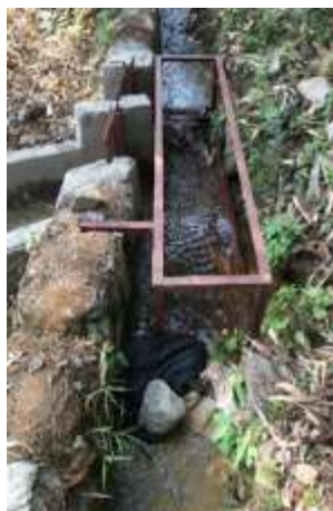
(左) 水路の水を Kingyo へ導水するためのパイプ
