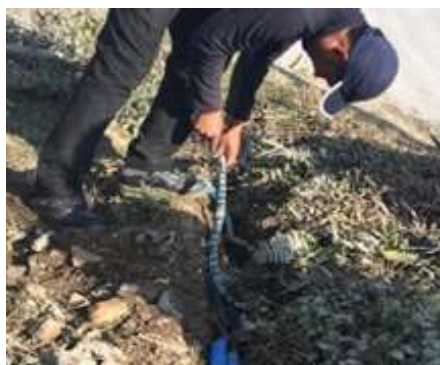
住民や動物（牛）が踏まないよう、Cappa のコードを地中のパイプに埋める
