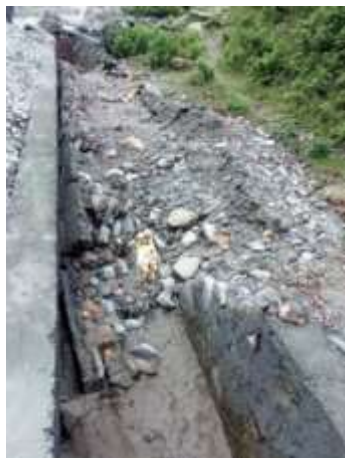
崩壊した直後の水路写真 2018 年 5 月 4 日
