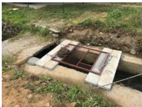
製品導入のための枠組み完成
