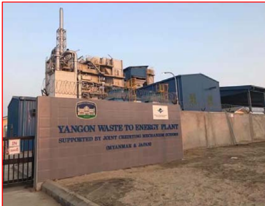
【写真 3 : シュエピーター地区廃棄物焼却+発電所】
