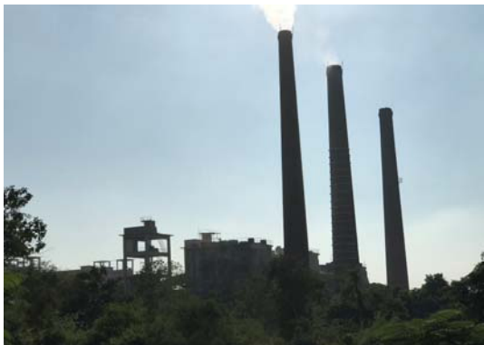
【写真 7 : 訪問したセメント会社の外観】
