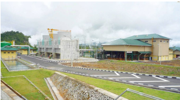
円借款により完成したインドネシアのラヘンドン地熱発電所（ラヘンドン地熱発電所拡張事業） 2009年2月
