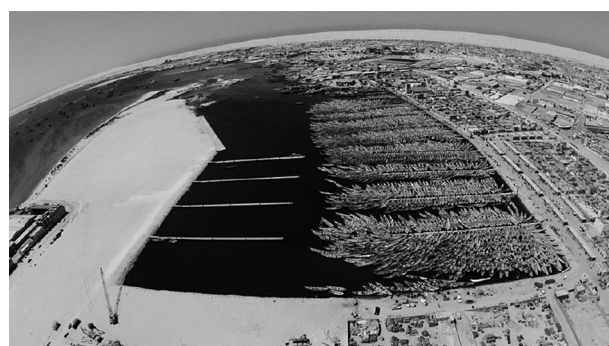
無償資金協力（ヌアディブ漁港拡張整備計画、2013年）により整備されたモーリタニア・ヌアディブ漁港の栈橋（左側、右側は既存施設）
