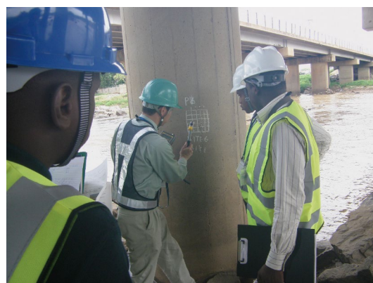
ナイジェリアの技術者に道路構造物の点検技術を紹介する日本企業の専門家（コンクリートテスター〈CTS〉を用いた道路付帯コンクリート構造物の点検技術の普及・実証事業）〈中小企業海外展開支援〉 2014年3月
