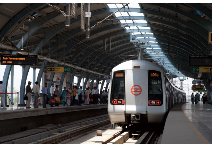
インド「デリーメトロ」開通（デリー高速輸送システム建設事業） 〈有償資金協力〉 2002年12月
