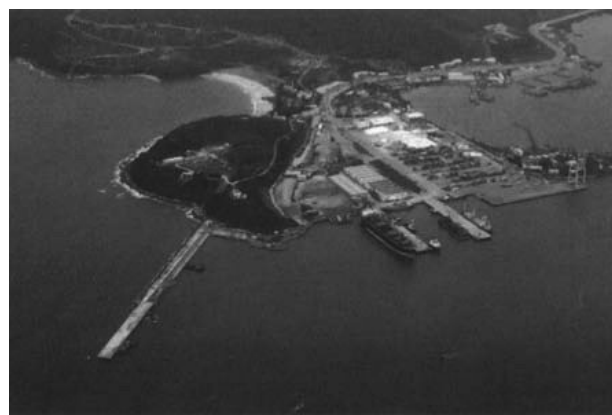
「ダナン港改良事業」により改善された同港ティエンサ・ターミナル
