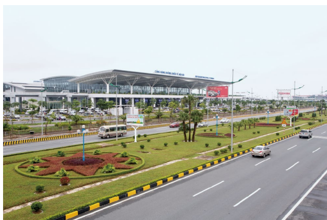
ベトナム・ノイバイ国際空港第二旅客ターミナルビルが運用開始（ノイバイ国際空港第二旅客ターミナルビル建設事業）〈有償資金協力〉 2014年12月
