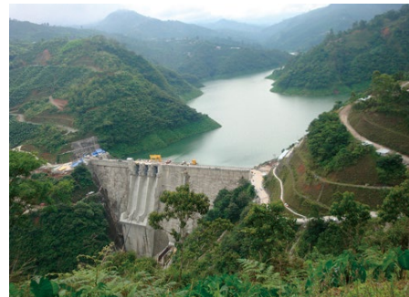
コスタリカの持続的な経済成長を支えるピリス水力発電所が完工（ピリス水力発電所建設事業）〈有償資金協力〉 2011年9月
