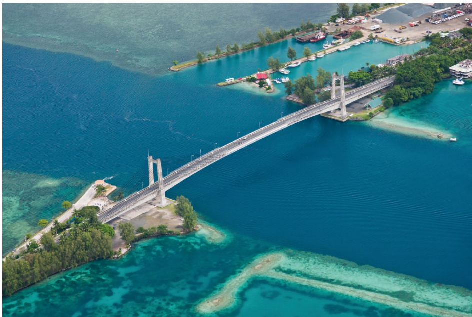
日本ーパラオ友好橋完成（新コロール・バベルダオブ橋建設計画）〈無償資金協力〉 2002年1月
