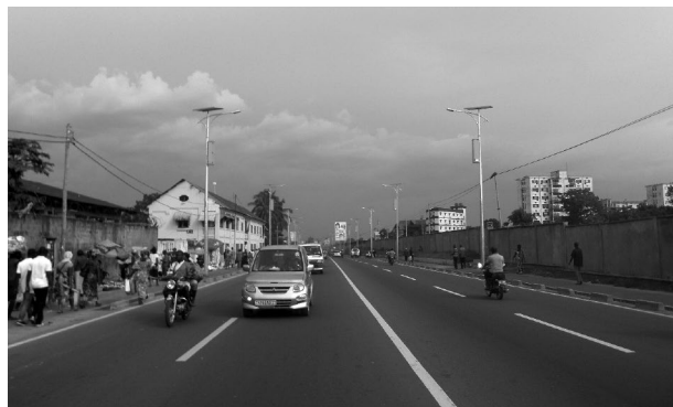
無償資金協力（キンシャサ市ポワ・ルー通り補修及び改修計画、2009年）により整備された道路
