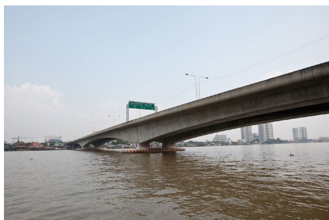
タイ・ラマ5世橋開通（ワットナコンイン橋及び付帯道路建設事業）〈有償資金協力〉 2002年6月
