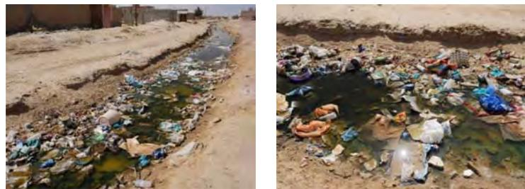
**Figure 2.10: Fossés d'évacuation des eaux pluviales dans les zones basses**
