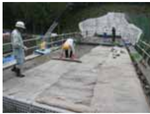
Séchage avec bâche
