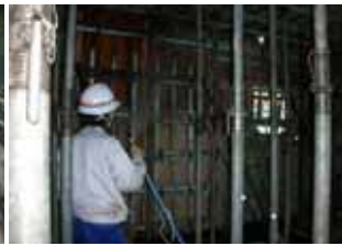
Aspersion également sur le coffre
