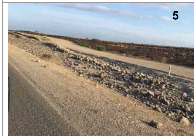
国道1号線サイト調査（3）
