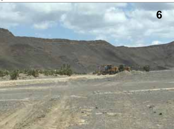
国道1号線サイト調査（4）
