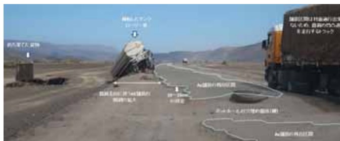
国境から16km付近の損傷状況
