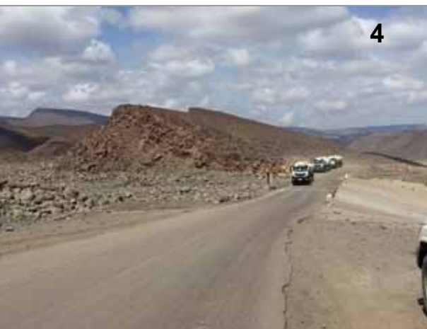
国道1号線サイト調査（2）
