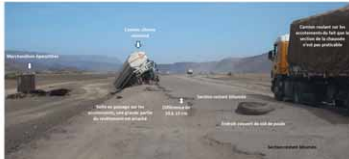
Situation des dommages à 16 km de la frontière
