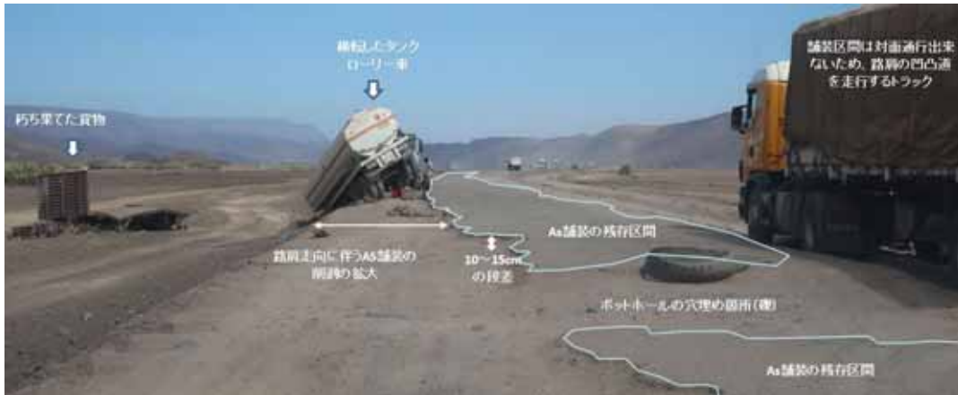
図2-2.2 道路舗装対象区間の損傷状況（国境から16km付近）
