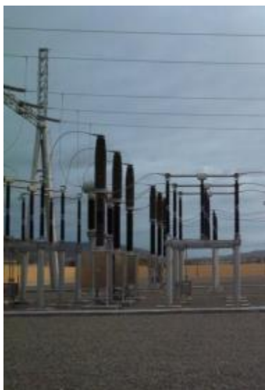
図 7-16 220kV 縦型ガス遮断器
