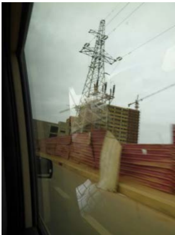
図 7-7 60kV 地中分岐鉄塔
