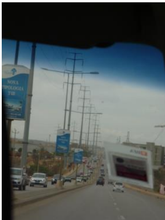
図 7-11 道路に沿った 220kV 送電線
