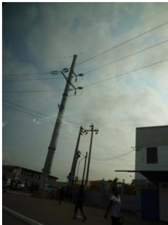
図 7-8 60kV 鋼管柱
