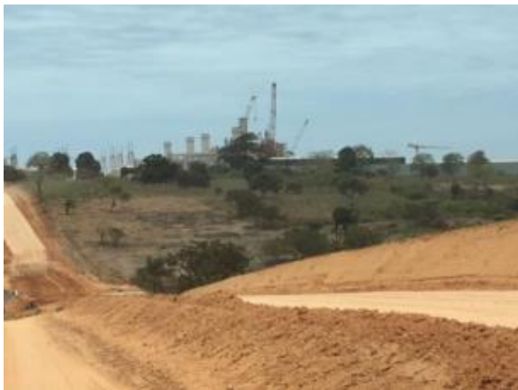
アクセス道路 (工事中) から発電所を望む
