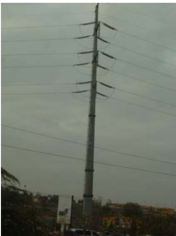
図 7-9 220kV 鋼管柱 (耐張)
