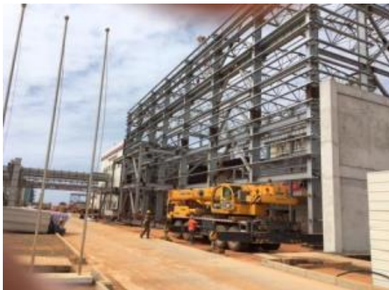
蒸気タービン建屋
