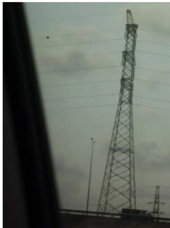
図 7-12 220kV アングル鉄塔
