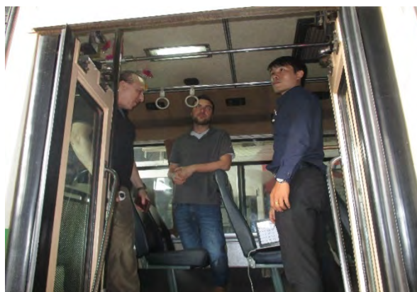
バス乗降センサー取付け作業 (2016年10月6日)
