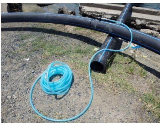
浮沈構造の加工とホース類の取付け
