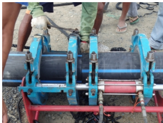
融着機を使用した融着作業
