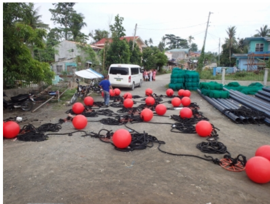
側張：陸上での組み立て
