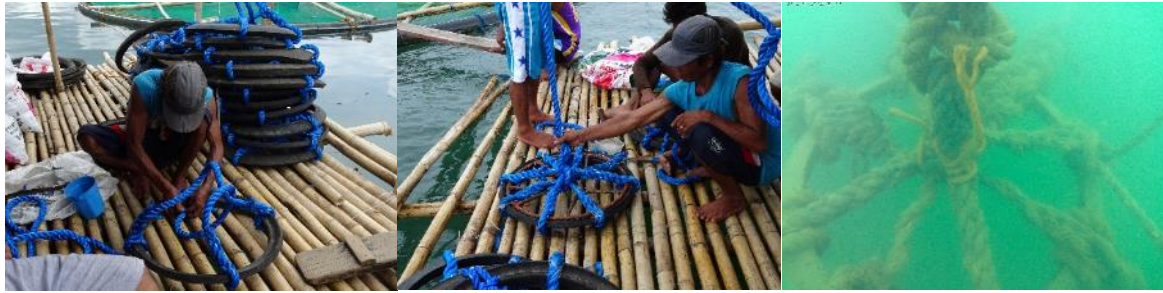
鉄製リングの補強
