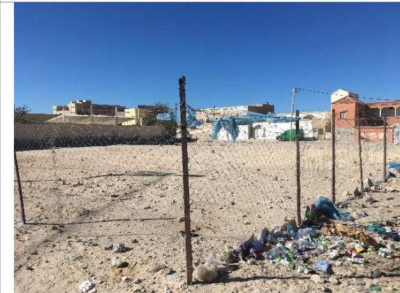
本案件サイトの敷地は瓦礫の撤去が行われ、囲いフェンスが施されている。
