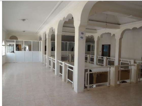
既存ヌアディブ検査所と別の場所にある管理部門建物。事務室の数が不足しているため廊下部分をパーティションで区切って使用している(写真奥)
