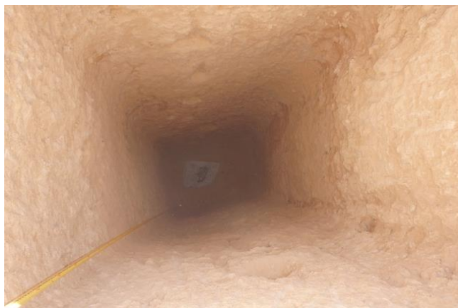
図 13 試掘 5m 地点の写真
