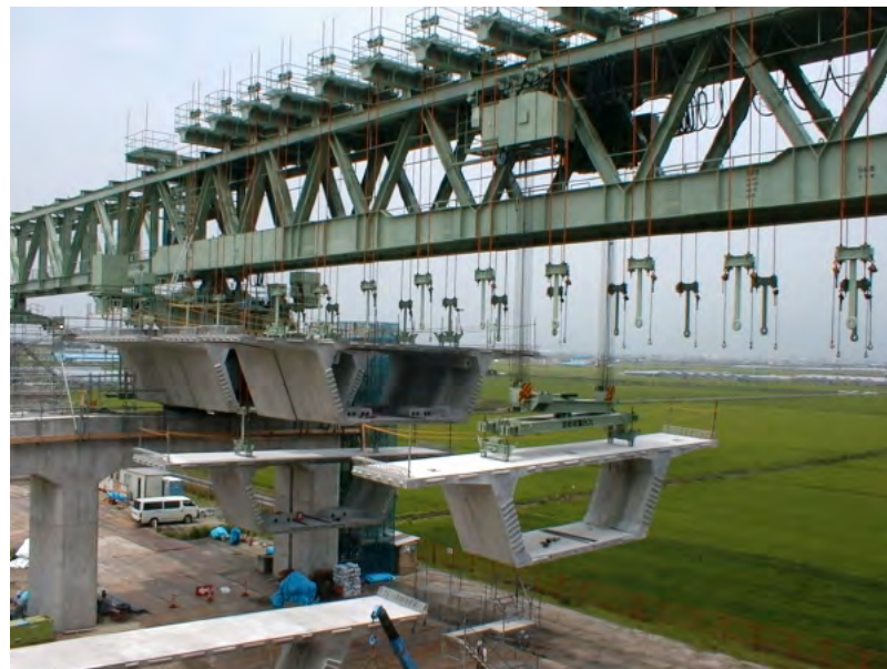
図 4.5.37 スパンバイスパン工法による桁架設
