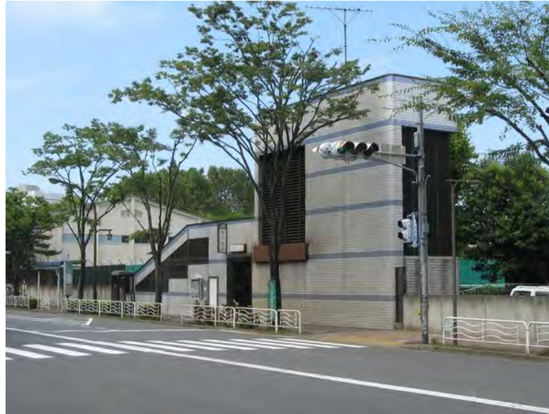
図 4.5.29 換気シャフトの設置例
