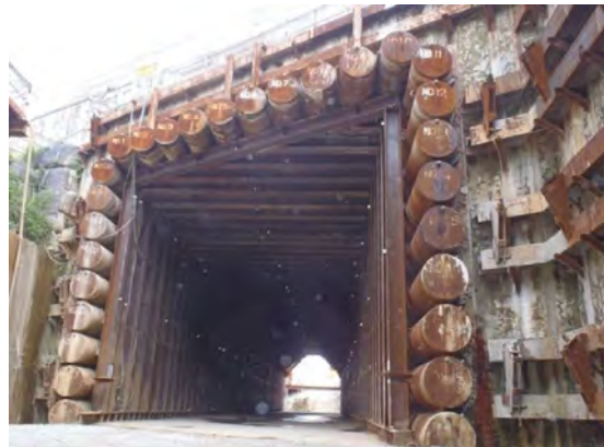
図 4.2.48 パイプルーフ工法イメージ図
