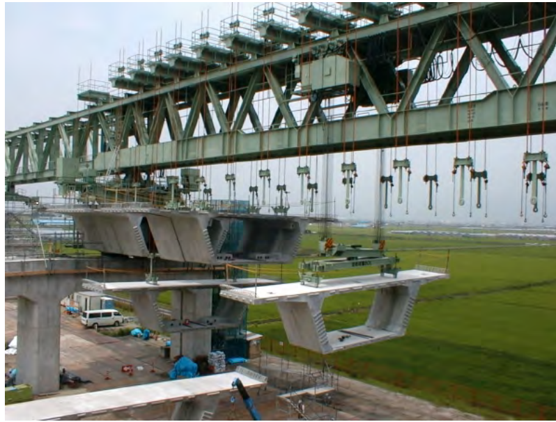
図 4.8.2 スパンバイスパン工法による桁架設
