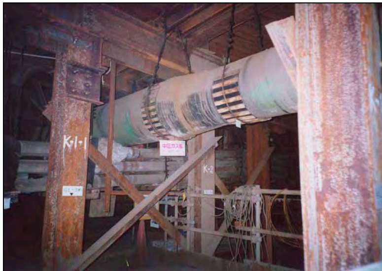
図 4.2.54 水道管の吊り防護
