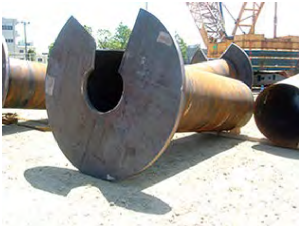
図 4.8.10 回転圧入鋼管杭
