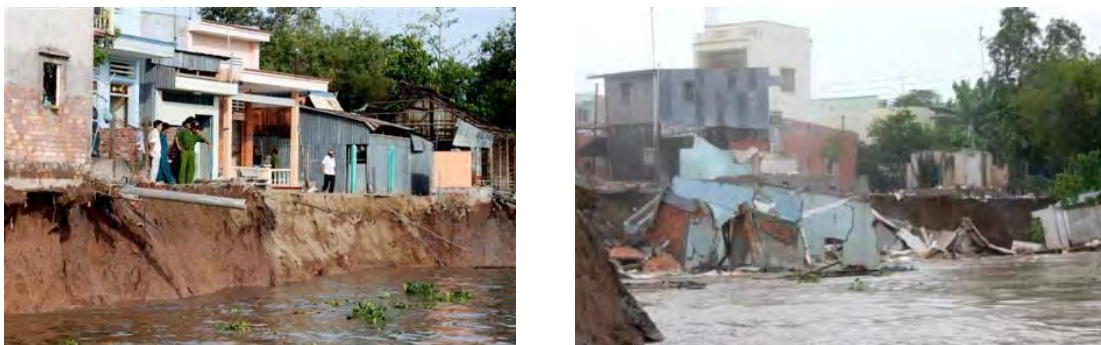
Ảnh 2.10 Thiệt hại do sạt lở bờ sông tỉnh An Giang
