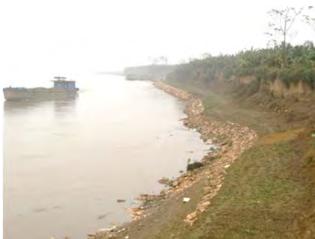
Ảnh 4.5 Công trình bảo vệ bờ sông bằng lát đá học thường thấy ở Việt Nam (trái: chỉ có lát đá; phải: lát đá kết hợp khung bê tông)
