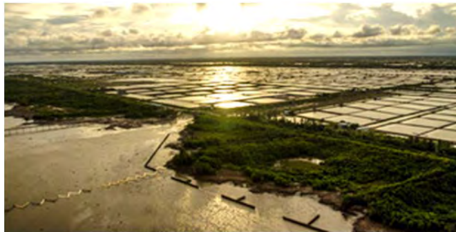
Ảnh 5.1 Kè chắn sóng hình chữ T vùng ven biển ĐBSCL do GIZ triển khai
