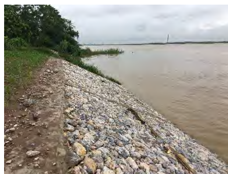
Ảnh 4.5 Công trình bảo vệ bờ sông bằng lát đá học thường thấy ở Việt Nam (trái: chỉ có lát đá; phải: lát đá kết hợp khung bê tông)
