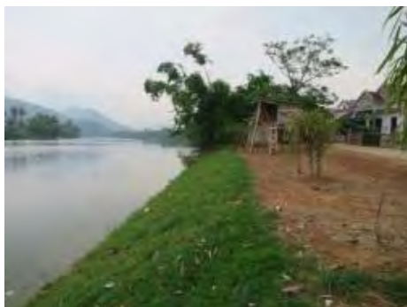
Hình ảnh mái bờ sông ở phân lưu của Sông Gianh, tỉnh Quảng Bình (công trình hoàn thành tháng 9/2014)
