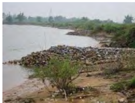
Hình ảnh mái bờ sông La, Hà Tĩnh (công trình hoàn thành tháng 4/2015)
