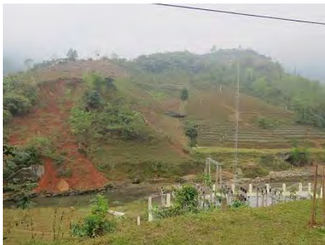
Ảnh 2.5 Thực trạng sườn núi không ổn định gần công trình phát điện (Tỉnh Lào Cai)
