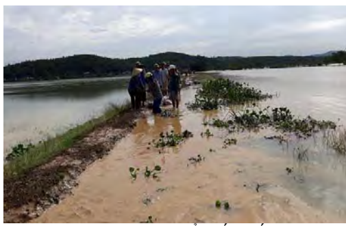
Tràn đê và giải pháp khẩn cấp (đắp bao cát) Bờ hữu sông Hoạt (tỉnh Thanh Hóa)
