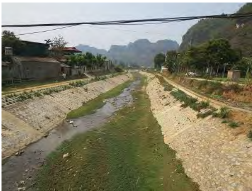
Ảnh 4.2 Xây dựng kênh dẫn lũ (tỉnh Sơn La)
