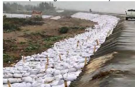
Giải pháp khẩn cấp bằng bao cát chống sạt chân mái kè (tỉnh Nam Định)
