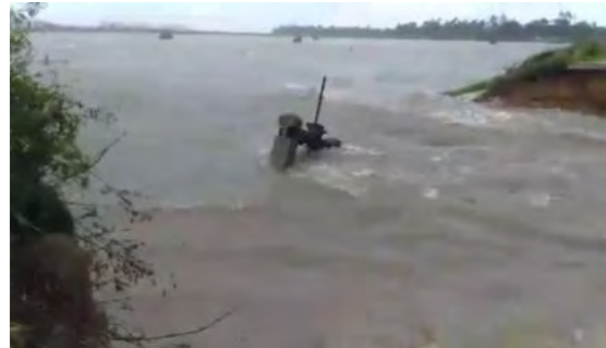
破堤した海岸堤防と排水樋門 Ta Nghen Dike (Ha Tinh 省)
