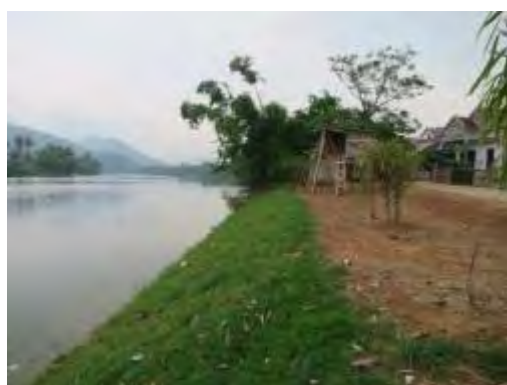
Quang Binh 省 Gianh 川支川における 河岸斜面の修復状況（施工後、2014 年 9 月）
