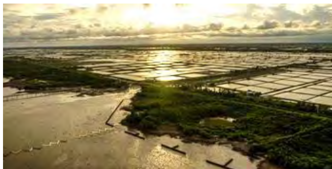
写真 5.1 GIZによるメコンデルタ沿岸での T 型防波堤 (離岸堤)
