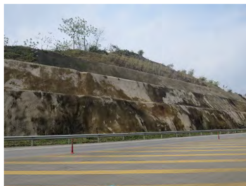
写真 4.3 国道沿い法面保護対策工施工状況 (Lao Cai 省)
