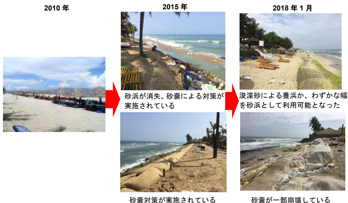
写真 4.9 Quang Nam 省 Cua Dai ビーチの応急対策
