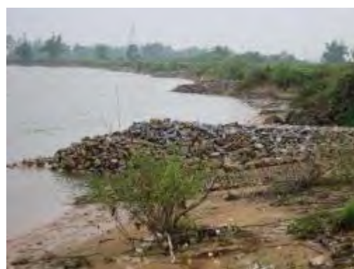
Ha Tinh 省 La 川における河岸斜面の修復状況 （施工中、2015 年 4 月）
