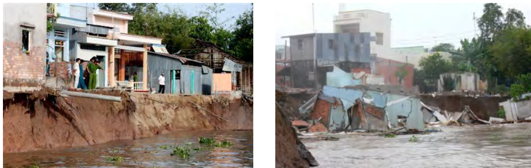
写真 2.10 An Giang 省の河岸侵食被災状況
