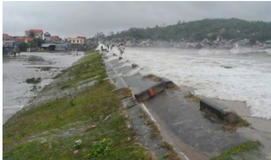
高潮による海水の越流 Hai Binh 海岸堤防 (Nam Dinh 省)
