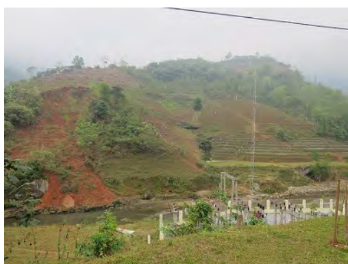
写真 2.5 発電施設（手前）に近接する 不安定斜面の状況 (Lao Cai 省) 写真内左側に見える地すべりは河道に達している。右側緩 傾斜の畑地は地すべり地形を呈する。 (2018 年 3 月 JICA 調査団撮影)
