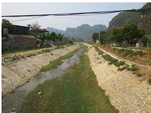
写真 4.2 土石流対策としての流路工施工状況 (Son La 省)
