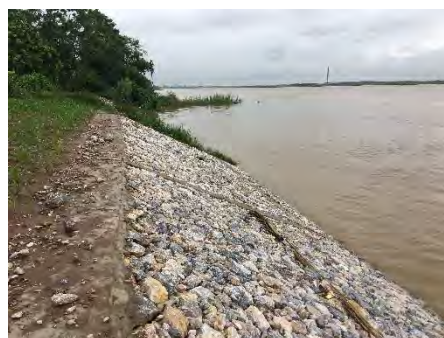
写真 4.5 ベトナムで見られる石張り護岸 (左：空積のみ、右：小口止め工の間に空積)
