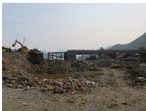
写真 2.4 土石流により一部が欠損した橋梁 (Son La 省) 2017 年 8 月に発生した大規模土石流災害により左岸 側橋脚が流出し、復旧作業中である。 (2018 年 3 月 JICA 調査団撮影)
