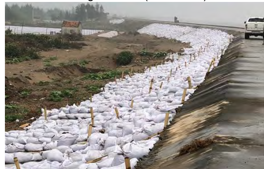
堤防法尻の洗掘を防止する応急措置 (Nam Dinh 省)
