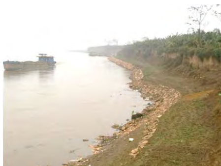
写真 4.5 ベトナムで見られる石張り護岸 (左：空積のみ、右：小口止め工の間に空積)
