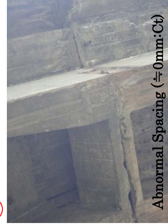
D P4-P5 : Gerber Type hinge
