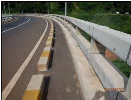
Photo 2-2-2 Bordure de trottoir discontinue (pont Kaaka)
