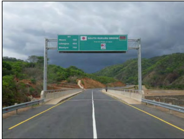
Projet de remplacement du pont au sud de Rukuru, route nationale 1, République du Malawi, achevé en décembre 2012
