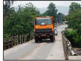
Photo ⑪: Véhicule lourd passant sur le pont Soumba dont la largeur est limitée
