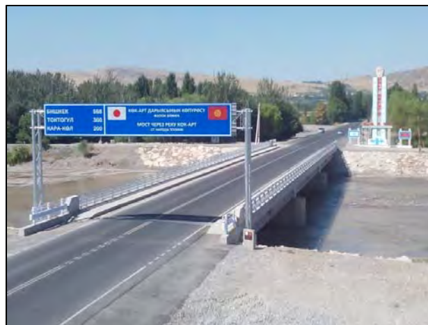
Projet de remplacement du pont sur le fleuve Kok-Art sur la route de Bishkek-Osh, République du Kirghizistan, achevé en octobre 2015
