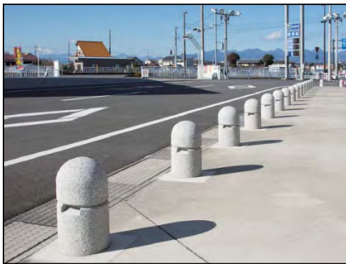
Photo 2-2-4 Borne de protection (exemple)
