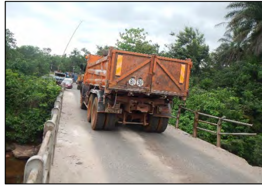
④ 大型車通過時の状況
