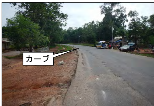
⑦ 橋の手前にあるかなりきついカーブ
