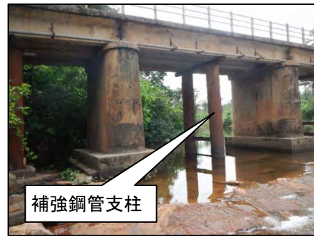
図 1-1-6 スンバ橋の補強状況
