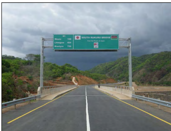
マラウイ共和国 国道一号線南ルクル橋架け替え計画 2012 年 12 月竣工
