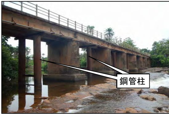
① 鋼管柱で補強されているスンバ橋
