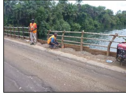
写真 2-1-1 スンバ橋での高欄取替工
