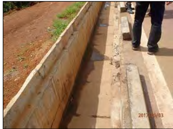
写真 3-2-3 一般部の縁石ブロック (国道1号)
