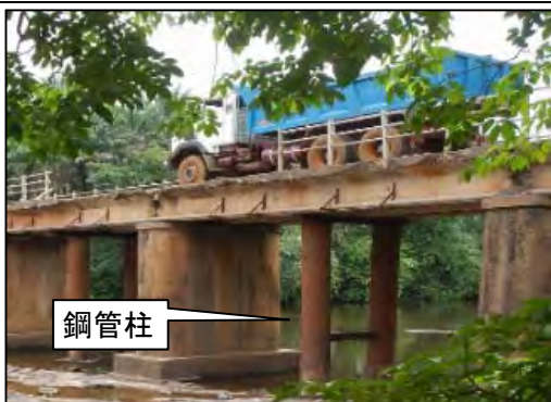
⑮ 補強されているスンバ橋を通過する大型車両
