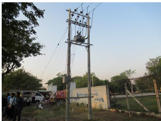
図 2-1 1 実運用配電線に設置した開閉器と変圧器
