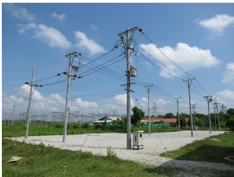
図 2-1 2 ネピドー研修所に設置した研修用模擬配電線
