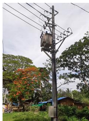
図 2-1 1 実運用配電線に設置した開閉器と変圧器
