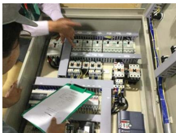
図3-4 工場検査（制御盤検査）
