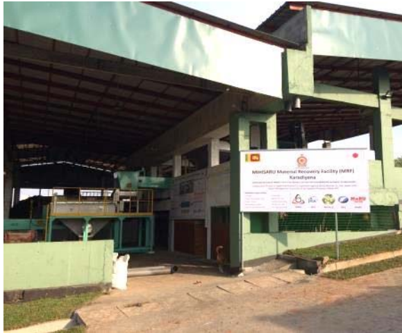
再資源化施設建屋外観 (2018. 02)
