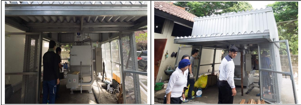
図 3-2 建屋内部（右）建屋（左）の設置完了状況
