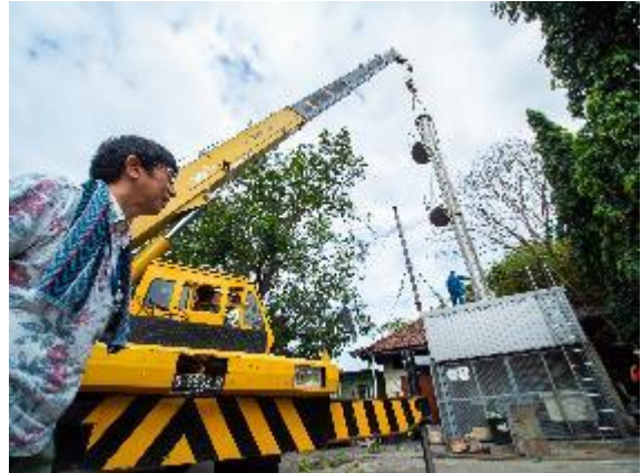
小型焼却炉煙突追設（工事中）
