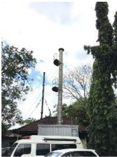
小型焼却炉煙突追設（完成状況）
