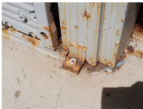
ウインチのコンクリートの土台 (水産局設置)
