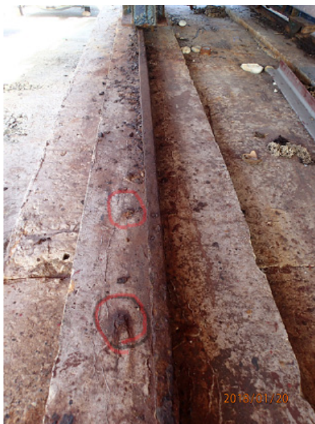
陸上側：コンクリートの下にボルトがある
