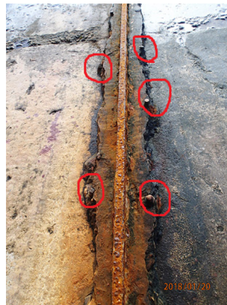
波打ち際：赤丸がボルト位置
