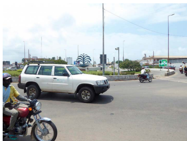
ベニワーズ交差点立体交差建設・道路改良事業 (2) モニュメントが設置され鉄道が交差点を通過
