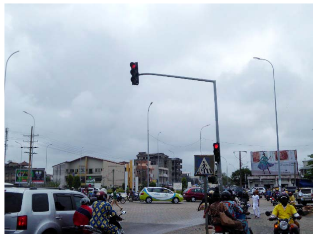
通称トヨタ前交差点立体交差建設・道路改良事業 (2) ロータリー形式にも関わらず信号機が設置されている。
