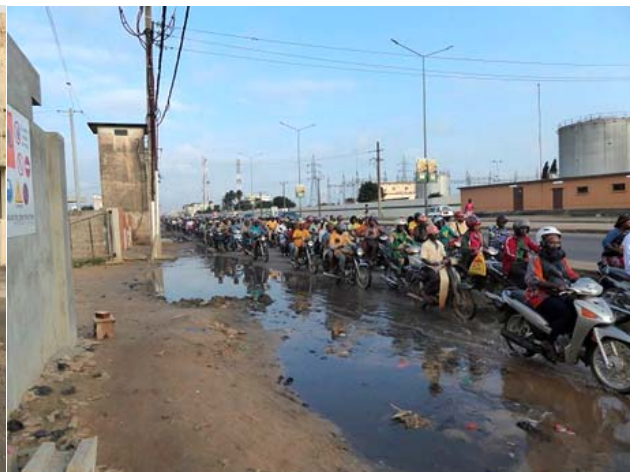
排水不良による道路の冠水（通称トヨタ前交差点）
