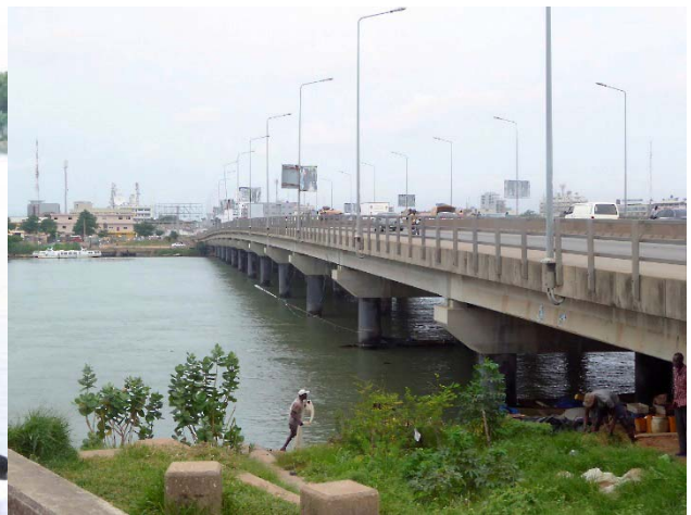
ドイツの支援によって整備された最も新しいラグーン橋梁
