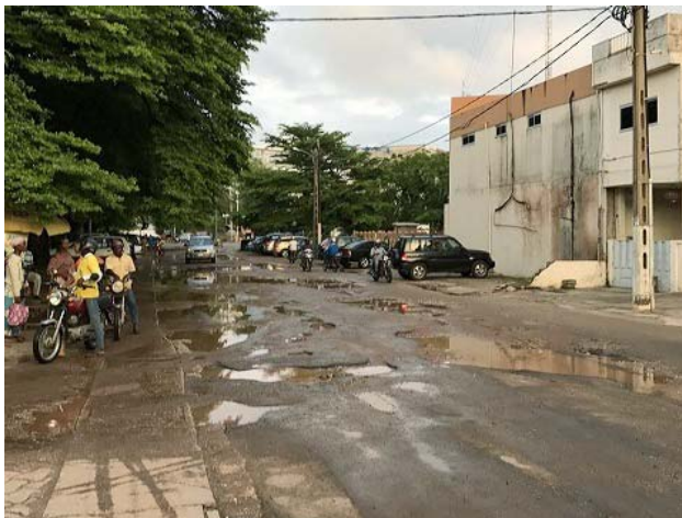
コトヌ市内の未舗装の街路状況
