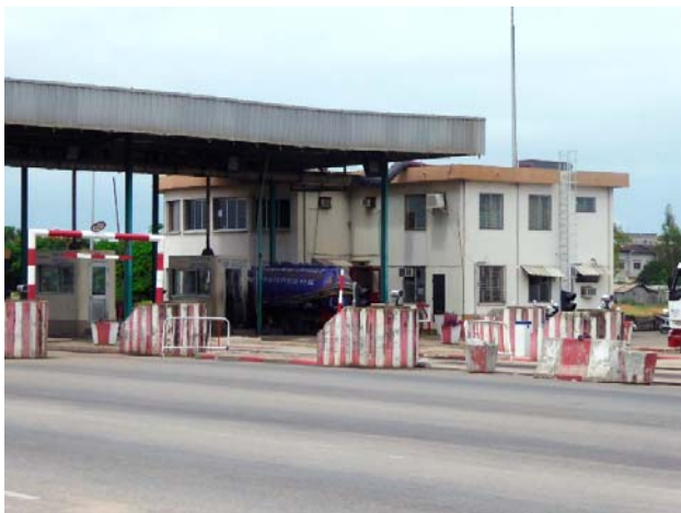
軸重計が設置されている有料道路料金所
