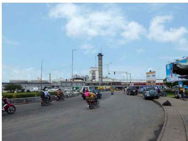
ベニワーズ交差点立体交差建設・道路改良事業 (1) ロータリー式平面交差点
