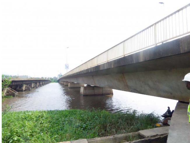
セメボジ・ポルトノボ高速道路整備 ポルトノボ手前の橋梁
