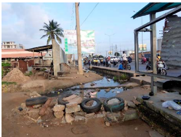
道路排水流末の未整備による水たまり
