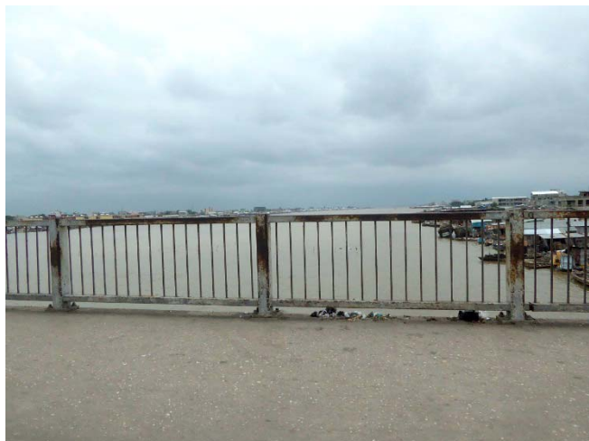
コトヌ北部バイパス建設計画 ラグーン橋梁より北バイパス方向を望む。
