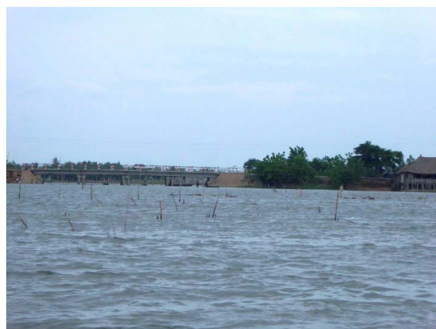
アヘメ港橋梁整備 (2) 橋長が短く流れを阻害し土砂堆積の原因となっている。
