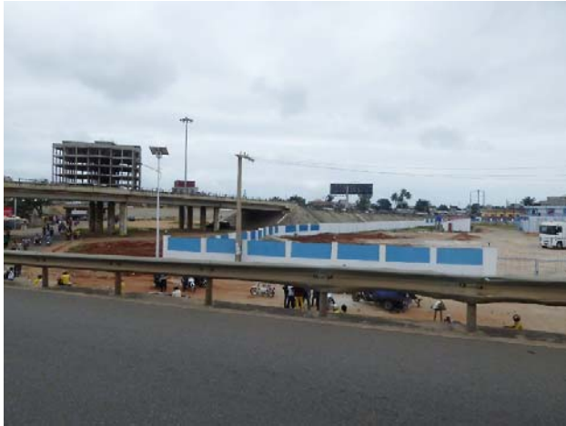
中国の支援によって建設された完全立体交差
