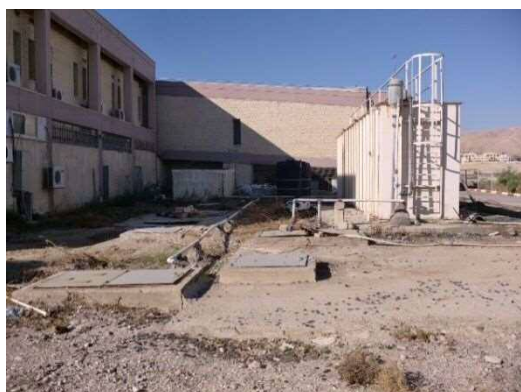
図 2.13.2 排水処理施設前景
