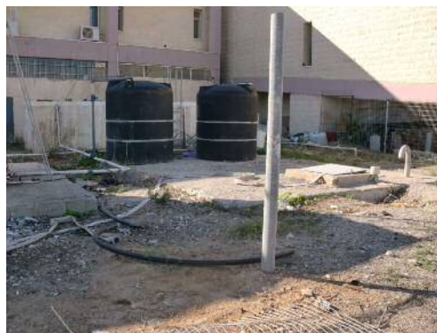
図 2.13.3 化学物質除去の前処理施設
