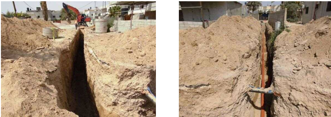
図 2.22.2 AJ キャンプ内の下水管網の布設工事写真
