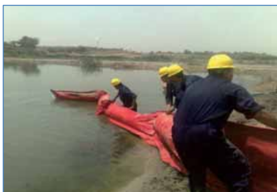
図 4.3-1(2) パイプラインからの油流出事故対応事例 (中部：パイプラインの河川横断部における流出事故)
