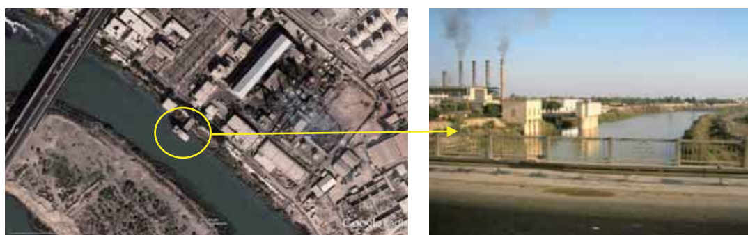
図 4.5-1(8) Al Rashid 火力発電所の取水設備 (バグダッド市)
