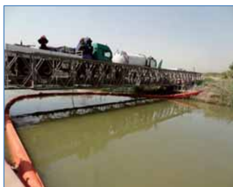
図 4.3-1(2) パイプラインからの油流出事故対応事例 (中部：パイプラインの河川横断部における流出事故)
