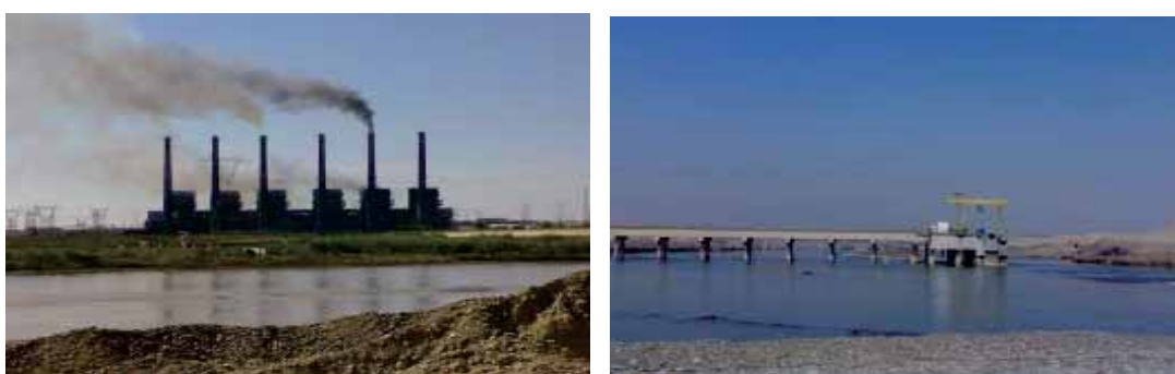
図 4.5-1(4) ベイジ火力発電所の取水ポンプ
