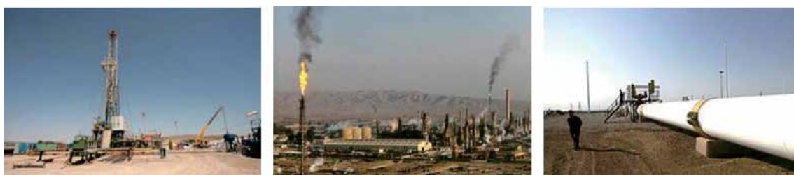
図 3.1-1 陸上原油生産施設及び原油パイプライン
