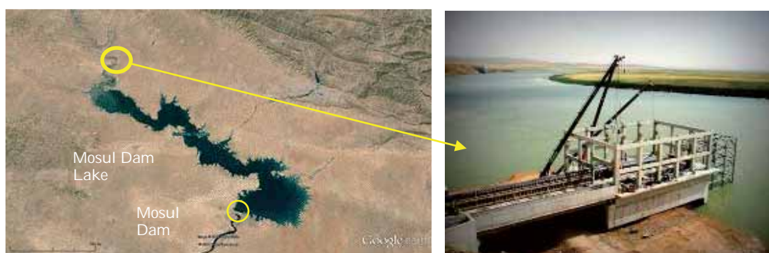
図 4.5-1(2) チグリス川及び Mosul Dam Lake 付近のポンプ取水口
