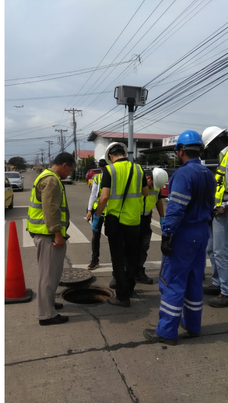
OJT en una tubería de alcantarillado
