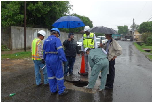
Inspección visual del pozo de registro
