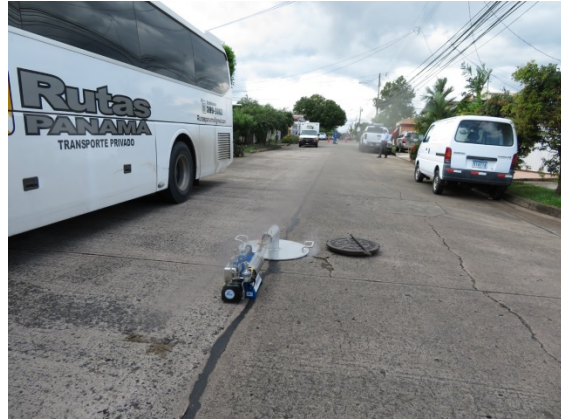
Estudio en el sector de Don Bosco (no hay conexiones erróneas)
