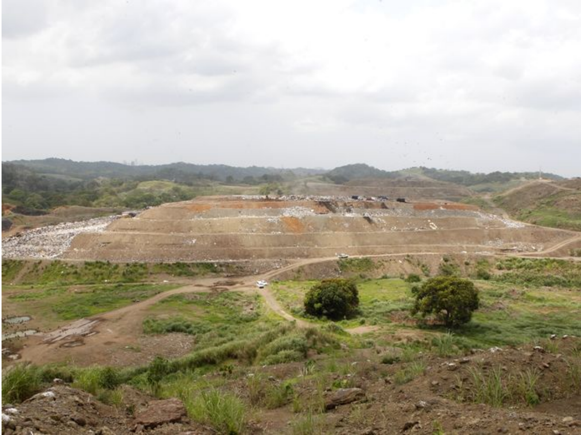
Estado del Relleno Sanitario de Cerro Patacón
