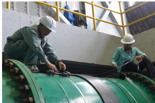
Imágenes de la instalación del caudalímetro en la estación de bombeo tipo JD
