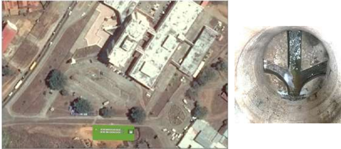
Figure 2.11 Malla instalada en la camara de inspección
