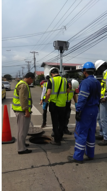
OJT en una tubería de alcantarillado
