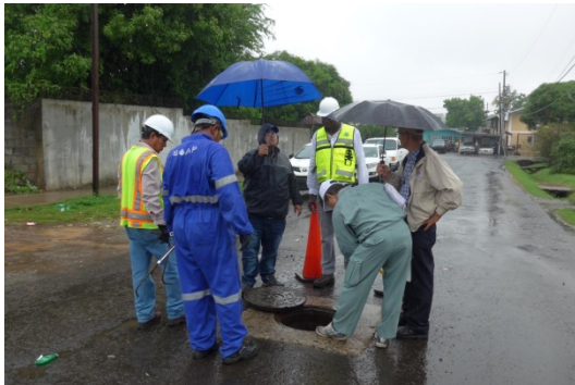
Inspección visual del pozo de registro
