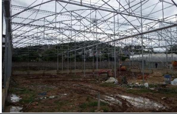
ハウス1の建設作業の様子。パイプの組み立てが完了した。ビニール張り工程に入る。
