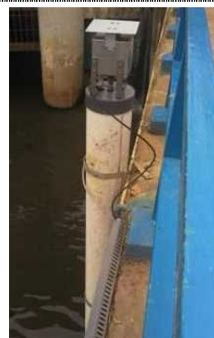
3号機（直浸け式）の設置
