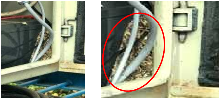
図 2.2 制御盤内の蟻塚（左）及び拡大図（右）
