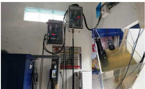
3号機（ポンプアップ式）の設置
