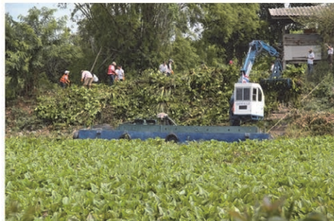
重機を用いたの駆除作業（アユタヤ県）
