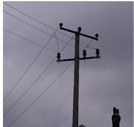
図 8.5-9 ピンポストがいしの 使用状況 (下段)
