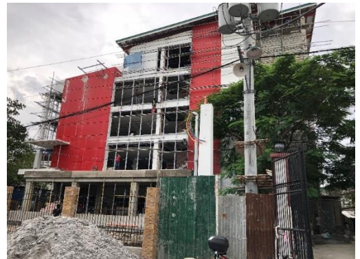
タギッグ市の現在建設中の高齢者事務所
