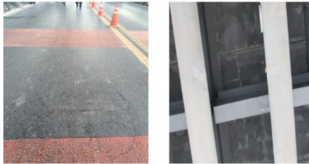
図 7 パッタナカン高架道路のコンクリートの様子(修繕後)
