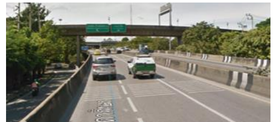
図 6 9 Ratchada 高架道路
