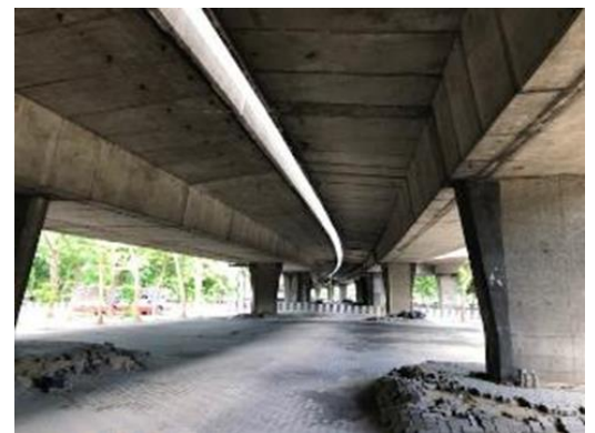
図 7 0 Ratchada 高架道路の高架下
