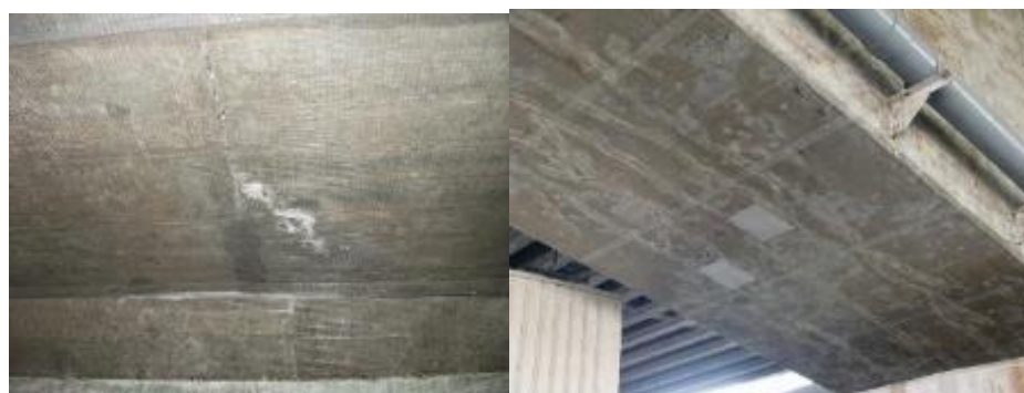
図 5 5 コーティング後の様子(補修跡が確認可能)
