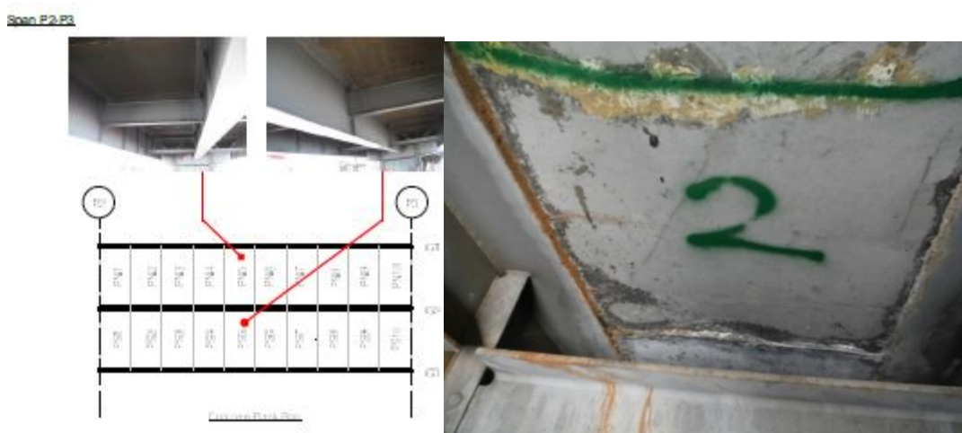
図 4 3 目視点検レイト修繕後の様子(左：目視点検後のレポート(例：Ding Dang 橋)、右：修繕後の様子)
