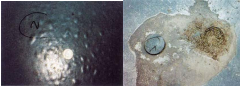
図 10 タイ国の一般的な表面保護工による「ふくれ」や「はがれ」 20
