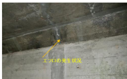
図 5 3 透明であるため、ひび割れのみならず、エフロ 121 の発生状況も確認できる
