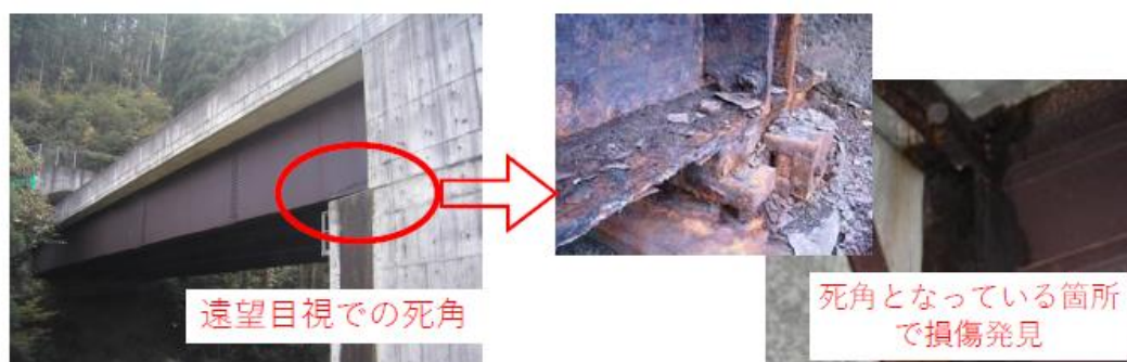
図 26 遠望目視で生じてしまう死角
