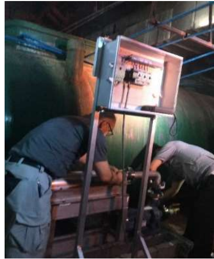
実験機のリミケットカイ・ホテルへの搬入・組立・設置作業2
