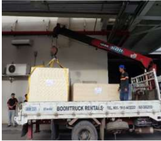
実験機のリミケットカイ・ホテルへの搬入・組立・設置作業1
