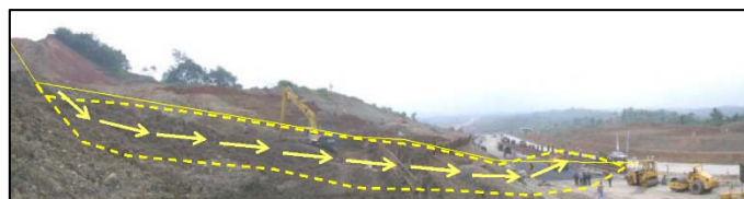
図 3-4 地すべり発生状況
