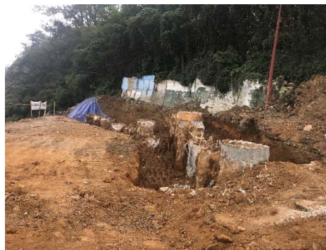
抑止杭の設置状況
