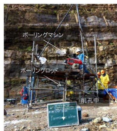
図 2-2 調査ボーリングの状況
