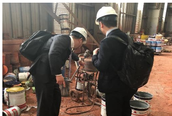
⑭鉄骨メーカーの塗装現場-2
