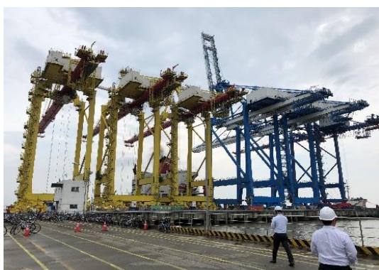
③屋外塗装所を視察
