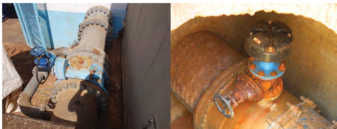
図 2 フランジの状況（左：ンゾベ浄水場、右：空気弁）
