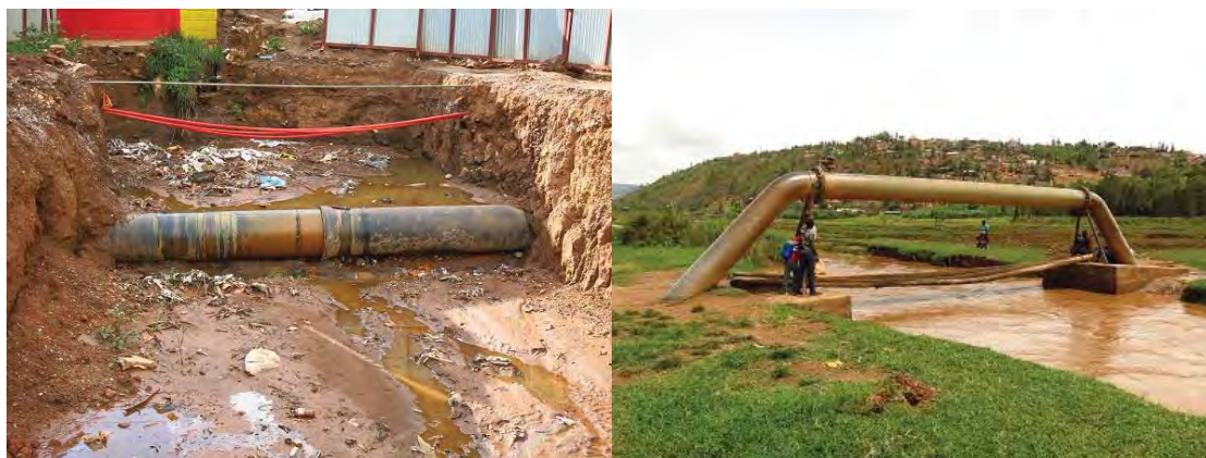
図 1 既存送水管（左：ダクタイル鋳鉄管、右：鋼管）
