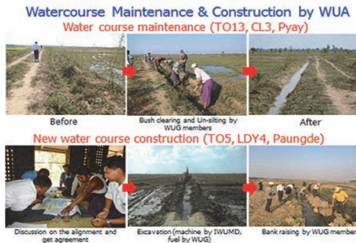
圃場内水路造成及び維持管理の様子
